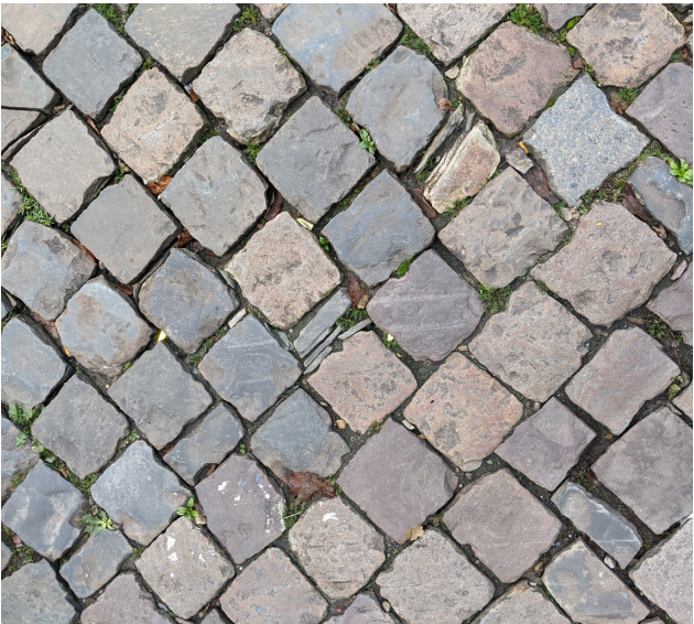
Rejointoyement détérioré des pavés
